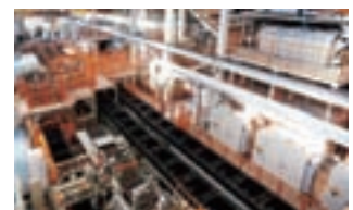
▲環境に配慮した新鑄造工場「美濃ファウンドリ」
