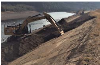
○3次元データを活かし施工
